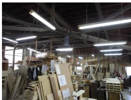
【 工場の蛍光灯 】
