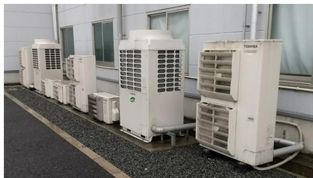
室外機の適切な設置例
