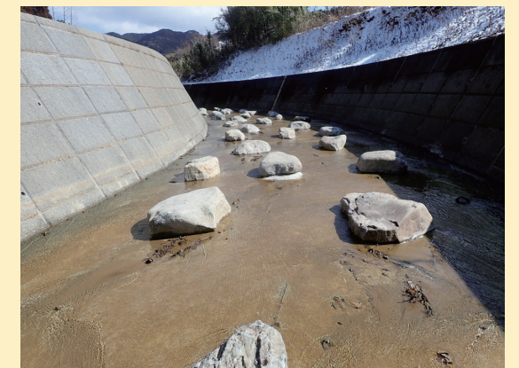
図3 川底までコンクリートで塗り固めた河川
