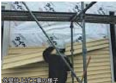
外壁仕上げ工事の様子
