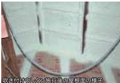
吹き付けウレタン施行後の屋根面の様子
