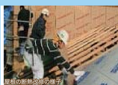
屋根の断熱改修の様子
