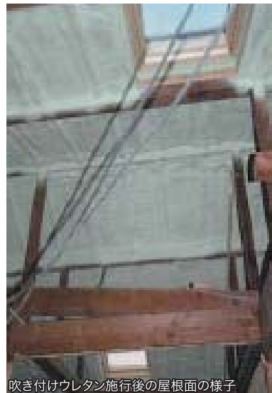
吹き付けウレタン施行後の屋根面の様子
