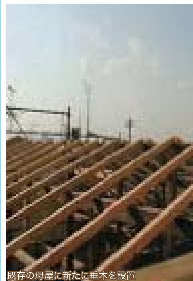
既存の母屋に新たに垂木を設置
