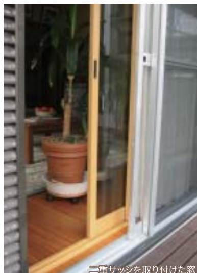
二重サッシを取り付けた窓
