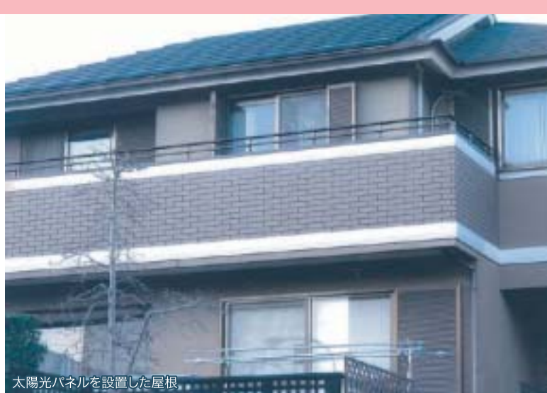
太陽光パネルを設置した屋根
