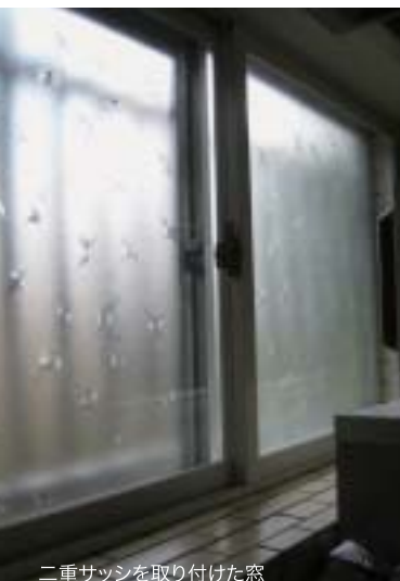
二重サッシを取り付けた窓
