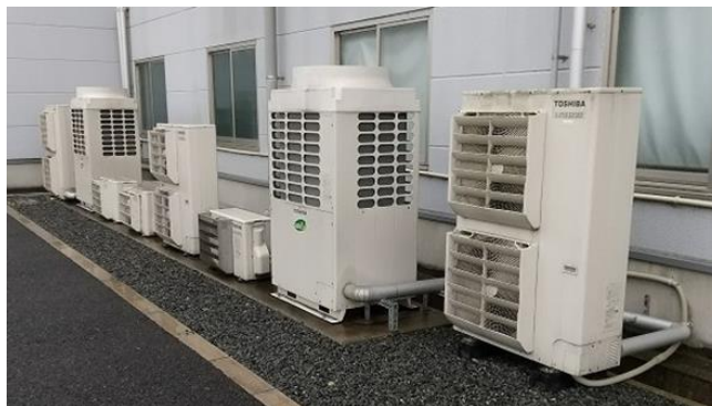
室外機の適切な設置例
