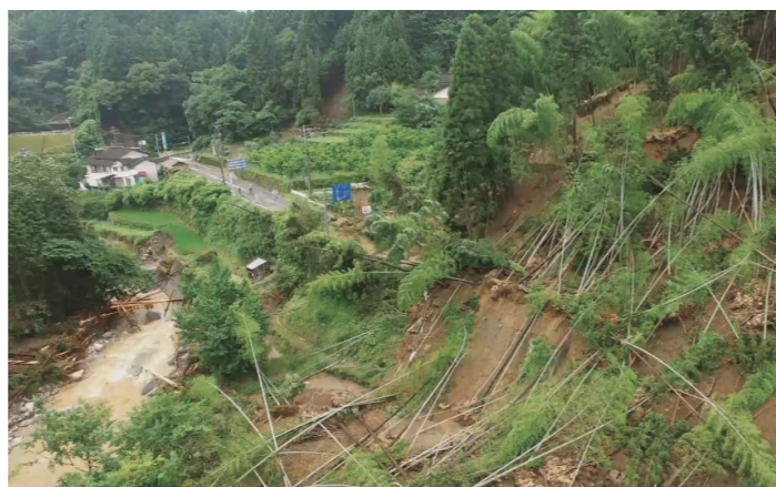
東峰村付近の状況 土砂崩れで道路が完全に寸断されています 国土交通省 国土地理院撮影
